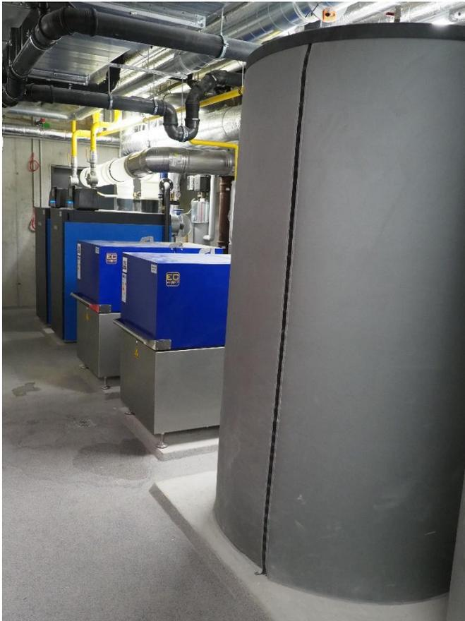
Zwei Brennwertkessel mit 300 kW und zwei BHKW`s mit jeweils 20 kW elektrischer Leistung.
