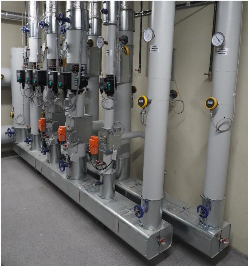
Durch das Versetzen der Heizungsverteiler ist das Aufbringen der Isolierung möglich.
