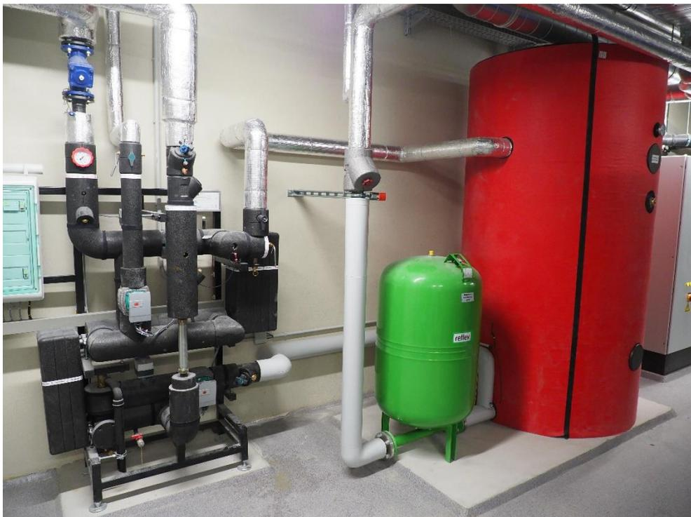
Der Heizungsverteiler mit Aufbau wurde bei uns in der Firma auf Maß gebaut.
